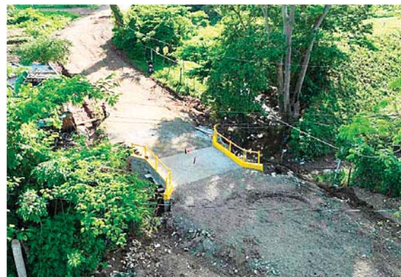
Vista área de la nueva caja puente construida en Cofradía.
