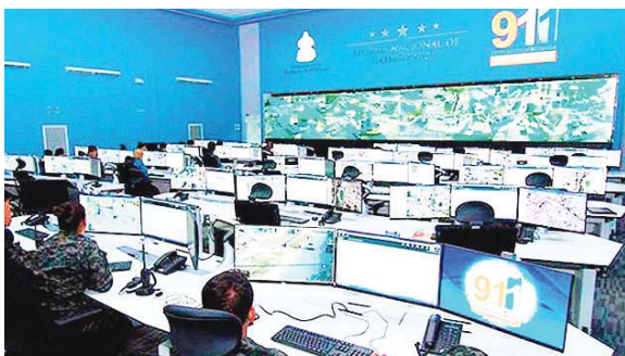
El Sistema de Emergencia 911 no está funcionando a pesar de ser una plataforma de última generación.
