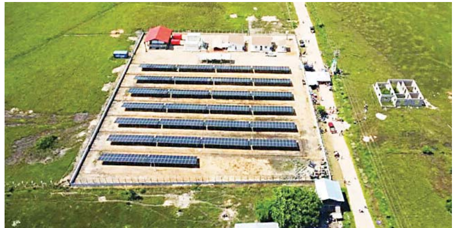
La planta de generación de energía inaugurada ayer en Brus Laguna tiene 741 paneles solares.
