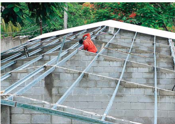
Con materiales proporcionados por los vecinos de la colonia La Pita, sector Cofradía, se edifican dos aulas en beneficio de 120 niños.
