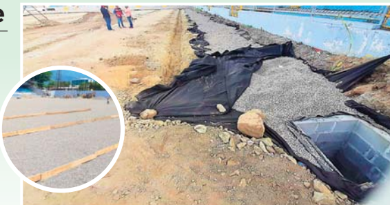
El Morazán tiene su nuevo sistema de drenaje.
