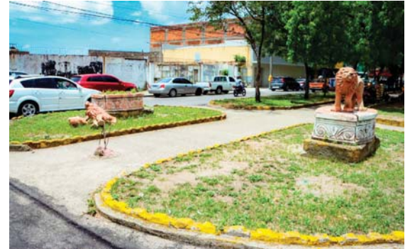
El deterioro de la Avenida Lempira es evidente.
