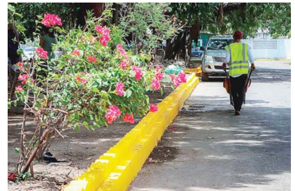
Se restaurará y pintará todos los elementos de concreto.
