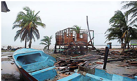
Las lluvias han afectado a muchas familias que viven en zonas vulnerables.
