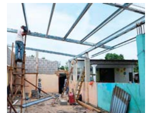
En la escuela Eusebio Fiallos desmontaron la estructura de techo.
