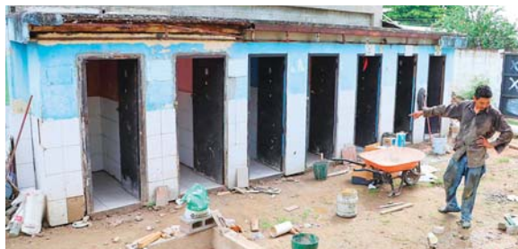
Unos 20 sanitarios se reparan en el Centro Básico Soledad Fernández.
