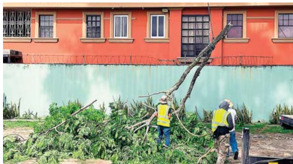
Desde el 2015 los vecinos han pedido que se corte el árbol, ya que ha ocasionado daños en las viviendas vecinas.
