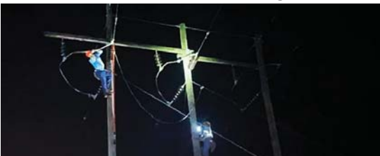
Los habitantes de Sulaco y Jocón denunciaron que tienen fallas en el tendido eléctrico.
