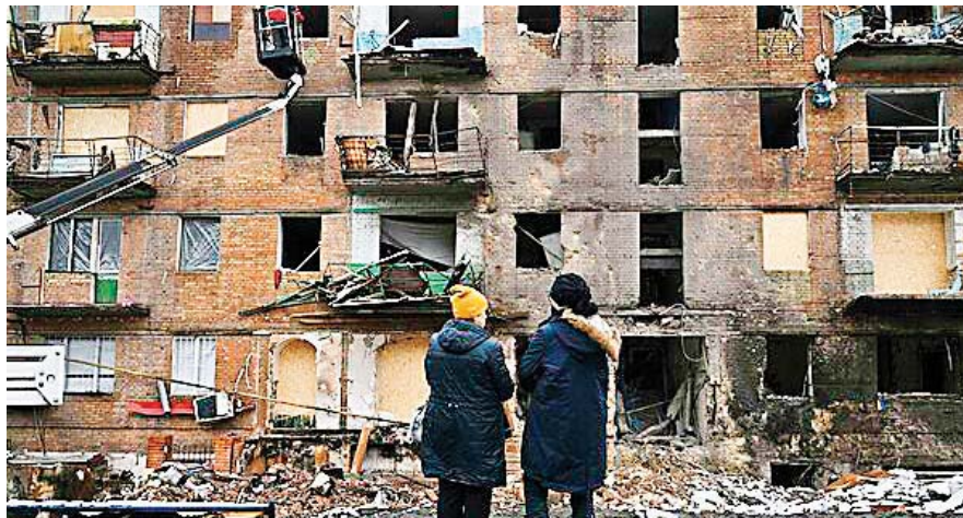
En el ataque edificios industriales y residenciales quedaron destruidos.
