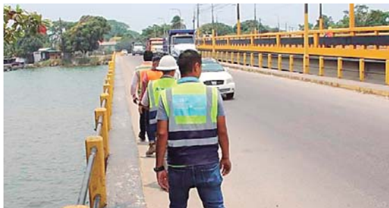
Mejoramiento de los puentes de acceso a Puerto Cortés, confirmó la SIT.
