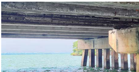
Las varillas salteadas son el reflejo que estos pasos estructuralmente ya dieron su vida útil.
