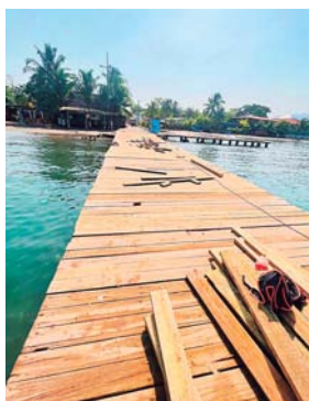
Ayer concluyó la reparación del muelle artesanal de Omoa.
