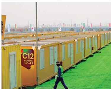
Complejo de 6,000 habitaciones prefabricadas en una zona semidesértica de la periferia de Doha.
