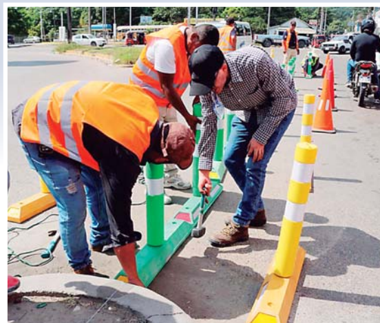
El principal bulevar de Villanueva luce con varios separadores y delineadores que impiden el estacionamiento y los virajes.
