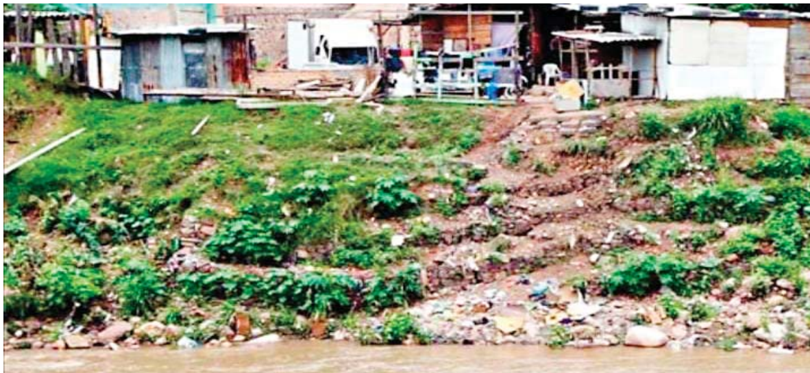
Las personas de escasos recursos económicos se ubican en zonas de riesgo y muy vulnerables ante las lluvias.
