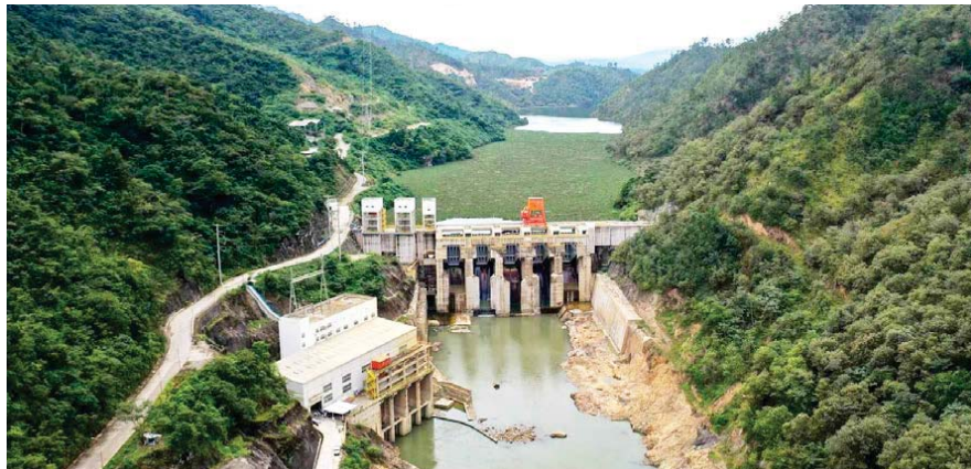
Patuca III es la segunda hidroeléctrica más grande de Honduras, con una inversión de 460 millones de dólares y una capacidad para generar 104 megavatios de energía limpia. Este proyecto comenzó a operar en diciembre 2020.
