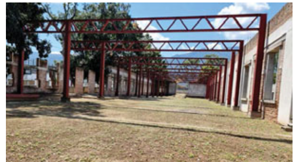
Vista interior del edificio.
