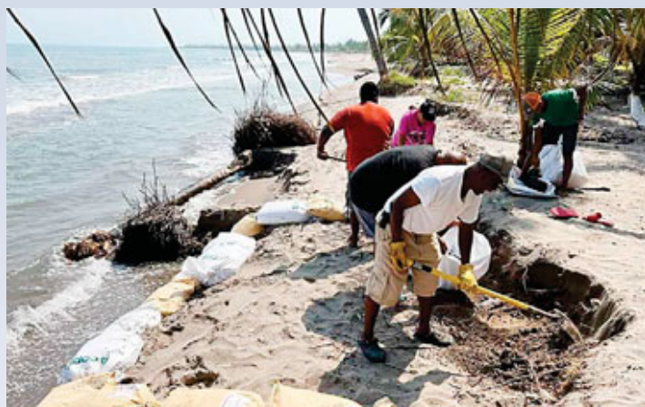
Vecinos del patronato de Travesía colocan varios sacos de arena a la orilla del mar.
