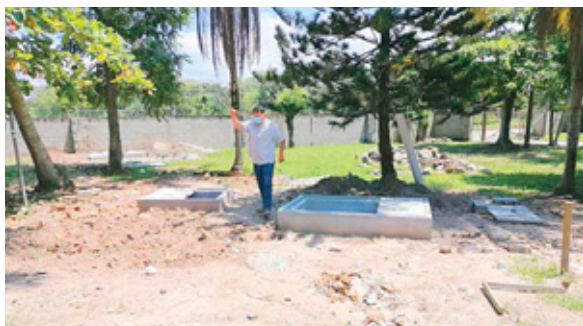
El sistema de aguas negras se reconstruyó por completo.
