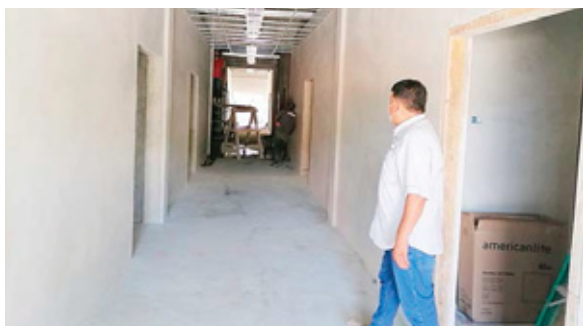
La construcción del área materno-infantil avanza en un 60 por ciento.
