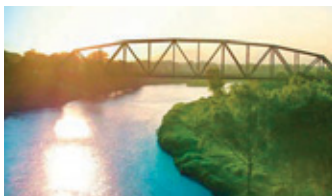
El río Ulúa, a su paso por diversas ciudades del Valle de Sula recoge grandes cantidades de aguas negras y desechos sólidos.
