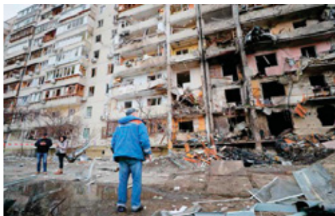
Varias personas contemplan los daños causados por los bombardeos rusos en una zona residencial de Kiev.
