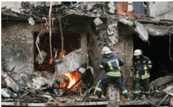
Miembros de los servicios de emergencia evalúan los daños causados por los bombardeos rusos sobre una zona residencial de Kiev.
