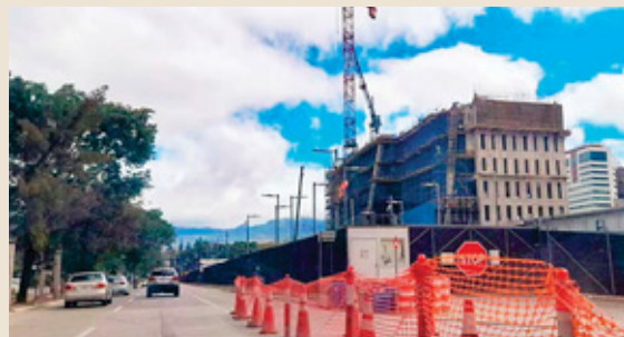
El edificio presenta importantes avances. Está previsto que lo terminen en octubre.
