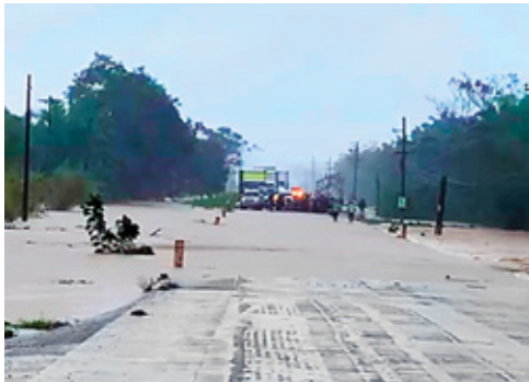
La circulación vehicular en la carretera CA-13, que comunica San Pedro Sula y La Ceiba, se cerró temporalmente por el desbordamiento del río Leán, entre Arizona y Tela.
