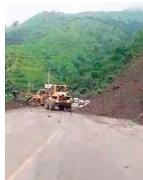
Maquinarias trabajaban para limpiar el camino y habilitar el paso.
