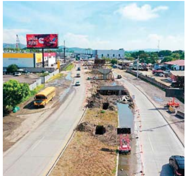
Intercambiador del Este, actualmente en construcción.
