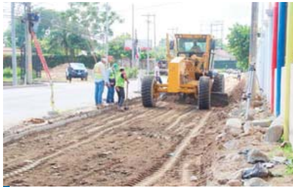
Los trabajos continúan avanzando a diario. Será un respiro vehicular ya que la ampliación de carriles permitirá un mejor flujo de automóviles.
