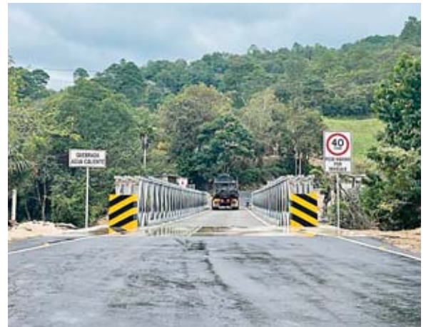
El puente está ubicado en el kilómetro 234 de la ruta vial CA-10, a la altura de la línea divisoria entre Honduras y Guatemala.
