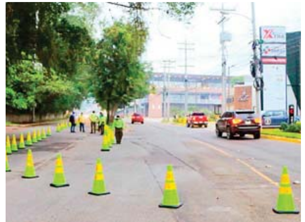
Las obras de pavimentación contribuyen a un mejor cuidado de los vehículos y permite mayor fluidez en el tráfico.
