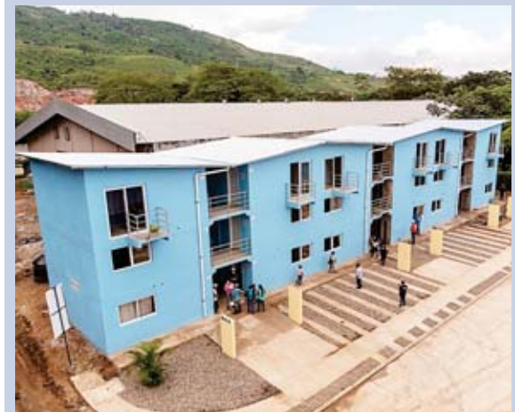
Los edificios multifamiliares son una modalidad de vivienda que se construye en Choloma Y Villanueva en Cortés, en total se construyen en estos municipios, 824 viviendas.
