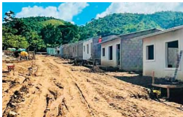
Avanza la construcción de viviendas en el municipio de Macuelizo, Santa Bárbara.
