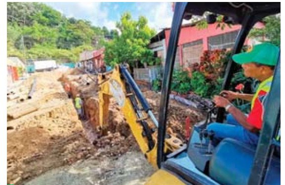
Esta obra mejorará el sistema de aguas lluvias y aguas negras.
