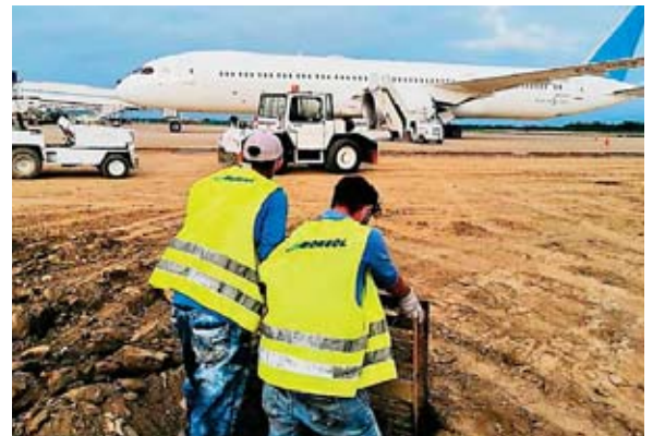
Monsol realizando trabajos en el aeropuerto.
