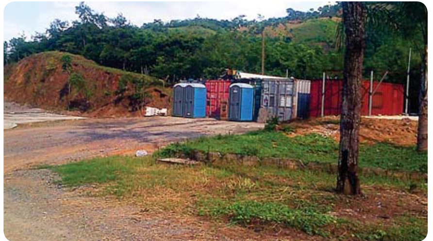
En las obras de construcción es fundamental contar con sanitarios portátiles.
