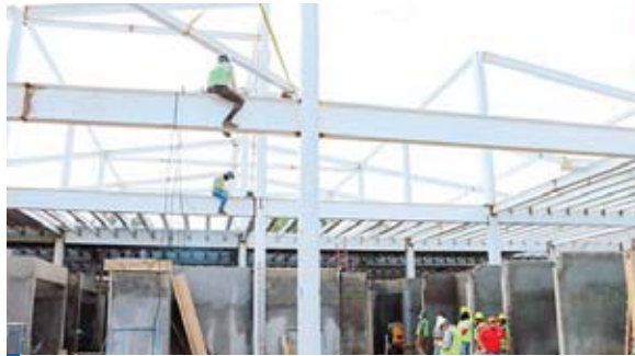
Las cuadrillas trabajan los 7 días de la semana por lo que en pocos meses la obra estará terminada.
