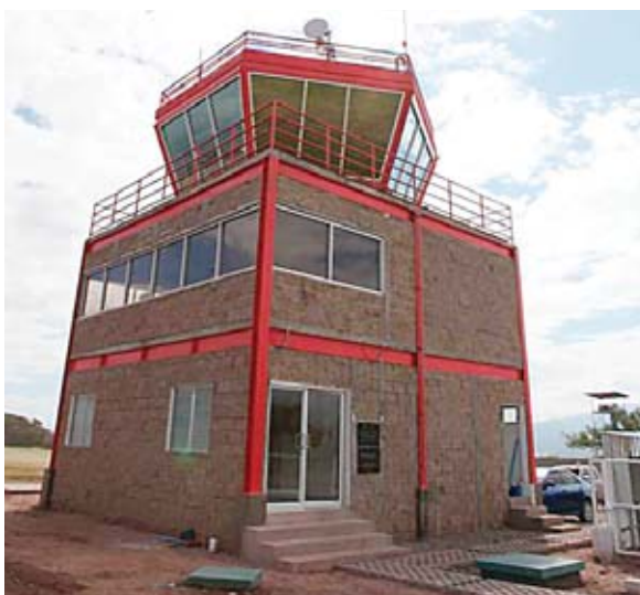
El aeropuerto ya contaba con la torre de la base aérea. Ahora cuenta con una torre propia.
