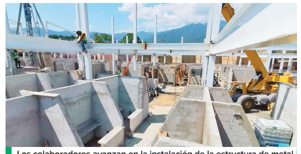
Los colaboradores avanzan en la instalación de la estructura de metal en la losa, además trabajos de entrepiso y elementos de techo en uno de los niveles.
