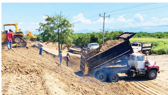
Las obras que se están ejecutando se extienden por los municipios de Villanueva, La Lima y San Manuel.
