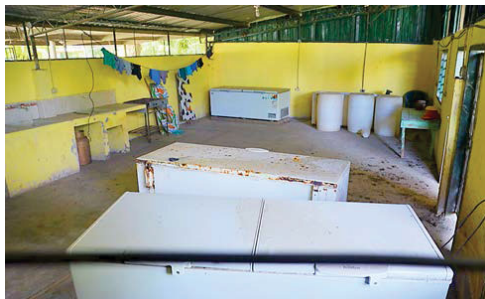
El agua dañó varios freezers que se utilizaban para almacenar pollos. La foto solo muestra algunos.
