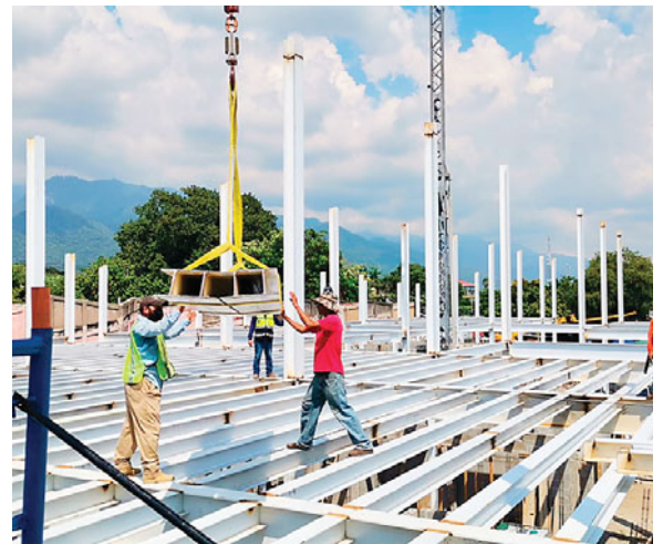
Los avances son notables con la reconstrucción del Mercado Guamilito, los colaboradores trabajan en la instalación de las vigas.
