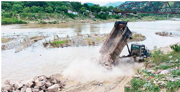
En la margen izquierda del río en el sector de Chamelecón, se construye una escollera de piedra con una longitud de 500 metros lineales.
