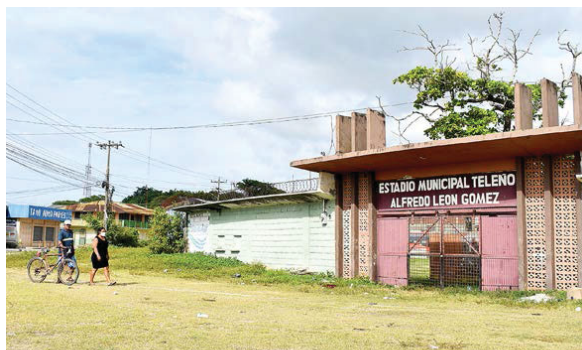
El Estadio Municipal Teleño se encuentra en muy malas condiciones, pero el equipo lo reacondiciona poco a poco.
