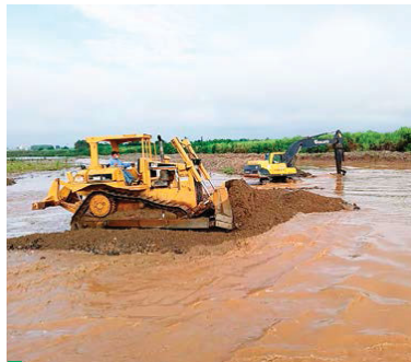
Las maquinarias trabajan actualmente en los vados.
