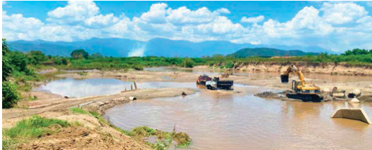
Los trabajos de reparación de los bordos en Guaruma II va a prevenir inundaciones y se espera que el proyecto se ejecute en un lapso de 45 a 90 días.
