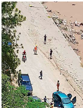
El mal estado de la carretera pudo jugar en contra de los jóvenes, indicaron autoridades.
