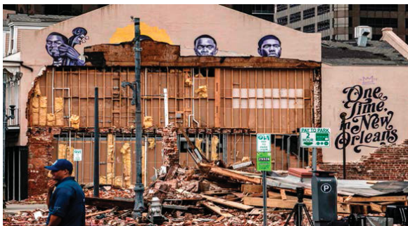
Ida causó destrucción en viviendas, oficinas y hospitales en el sur de Luisiana.
