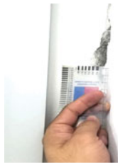
En la Estación Central de los Bomberos, ubicada en Prado Alto, surgieron algunas fisuras de 0.4 milímetros.
