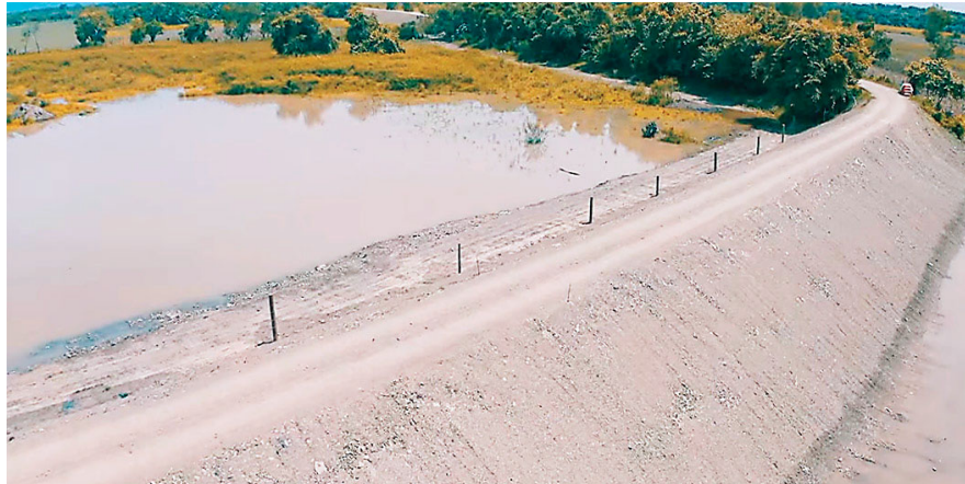
El bordo reconstruido de la aldea Montañuela. Sin embargo, existe el temor que las obras no estén suficientemente compactadas.
