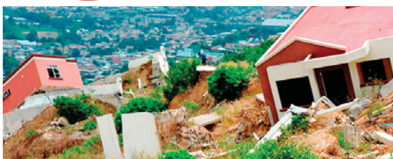
Muchas familias invirtieron sus ahorros en estas viviendas que al final quedaron destruidas porque el terreno no era apto para construir.
