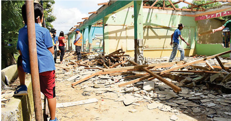
Ayer desde horas tempranas reiniciaron con los trabajos de demolición en la escuela Fesitranh II de la colonia Céleo Gonzales de esta ciudad.
