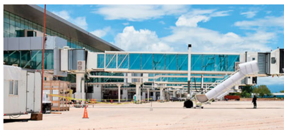
La obra comprende una construcción de 39.000 metros cuadrados, con once puertas de embarque, de ellas cuatro remotas, una rampa comercial y otra de carga
