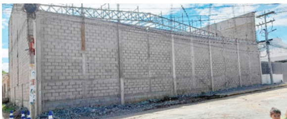
La empresa constructora demolió la noche del lunes el resto de paredes que eran una amenaza para la población.
