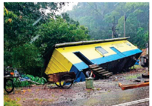
La posta de Pito Solo, que consistía en un contenedor, se dio vuelta al ser halada por una grúa que intentaba sacarla de un socavón.
