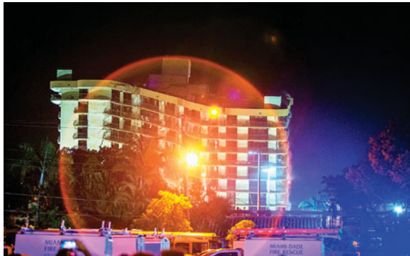
Los que decidieran quedarse en casa durante la demolición cerraron ventanas y puertas y taparon todas las posibles entradas de aire.
