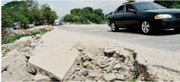
Con el paso de las tormentas Eta y Iota, la plancha sufrió un deterioro considerable que cada día empeora, convirtiéndose peligrosa para los que la transitan.
