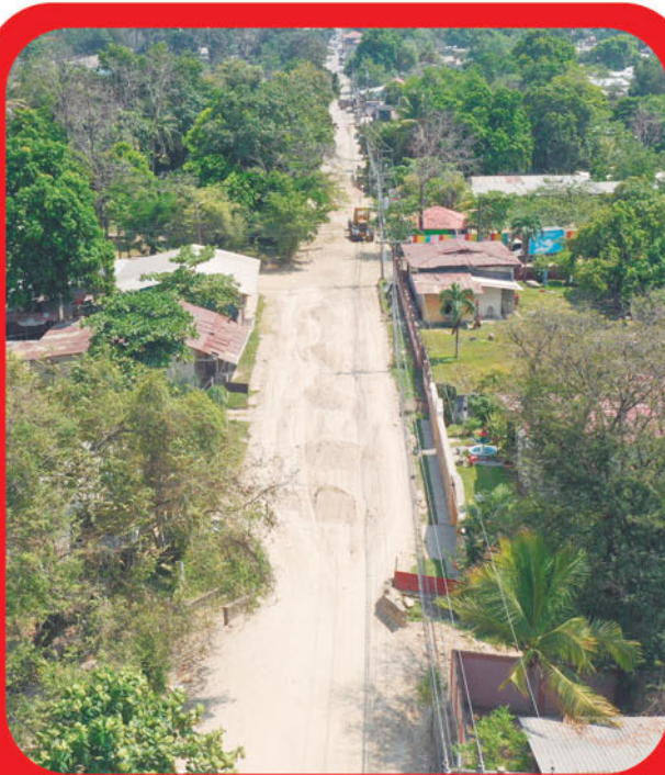
Pavimentación 4ta. Avenida barrio El Chaparro
