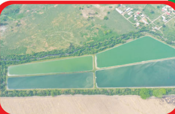
Lagunas de Oxidación, carretera hacia Ticamaya.
